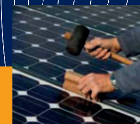
PANNEAUX SOLAIRES POMPES À CHALEUR ÉNERGIES RENOUVELABLES
